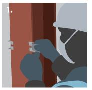
Installing Knauf Fixing Clips.
