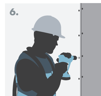
6. Fixing Knauf Fire Panel.
