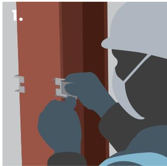
1. Installing Knauf Fixing Clips.
